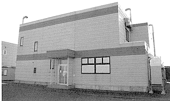
ダイオキシン類・特殊分析等試験棟
