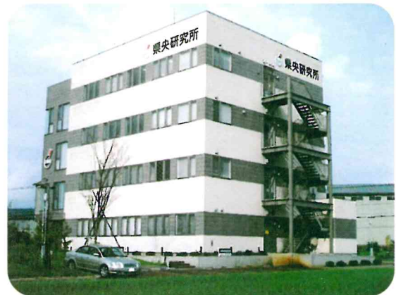
県央研究所建物全景
